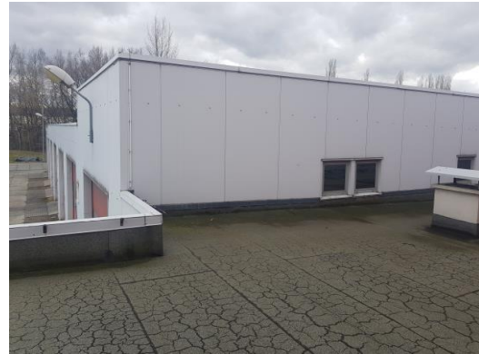
Kontynuacja remontu dachu budynku zajezdni
