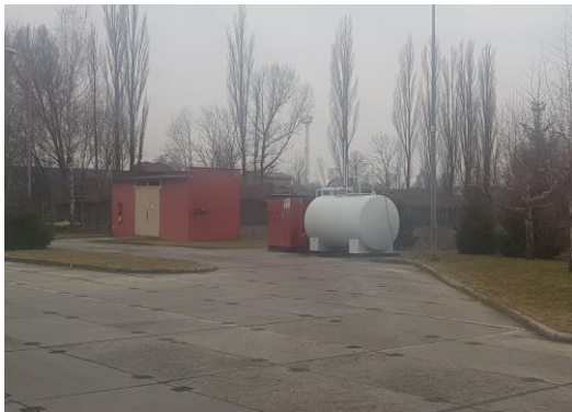
Zadaszenie wewnętrznej stacji paliw
