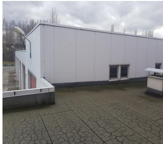
Naprawa części dachu budynku zajezdni
